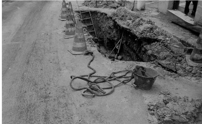
Figura 32: vala de construção
